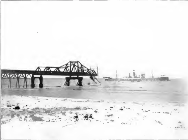
Aufn. der Südsee-Exp. der Wissenschaftl. Statung von Hamburg. D. D. „Mai Rickmers“ beim Phosphatladen auf Nauru. Die Ladebrücke ist über den Riffabfall hinaus- gebaut (Deutsch-Neuguinea).
